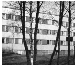
5 Provhuset före och efter ombyggnaden, från eternit till tegel och burspråk
