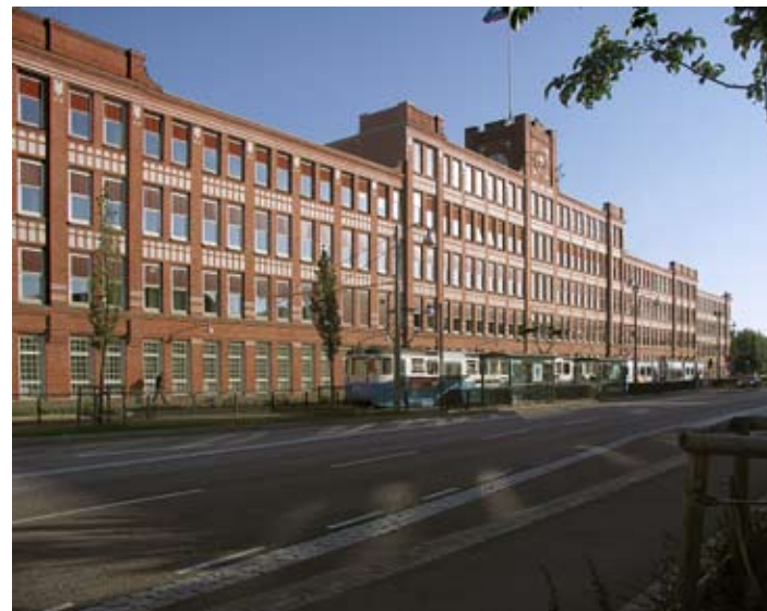
5 SKF:s fasad mot Artillerigatan med spårväg på egen banvall
