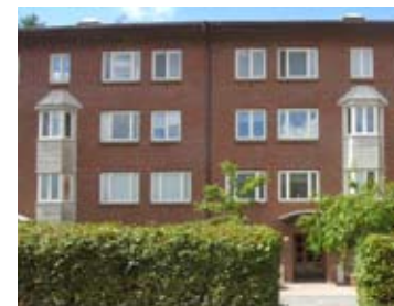
5 Provhuset före och efter ombyggnaden, från eternit till tegel och burspråk
