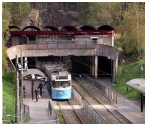
7 Teleskopgatans hållplats med väderskydd
