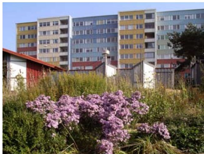
4 Siriusgatan med färggranna fasader och odlade gårdar
