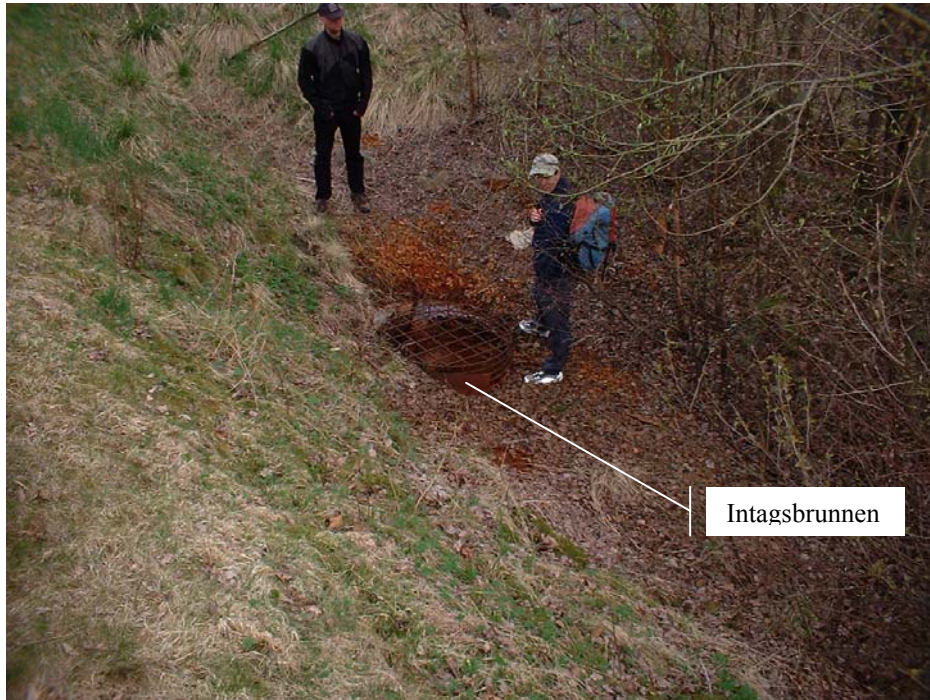
Figur 26. Intagsbrunnen, vilken är lägsta punkten i södra området (+94 m) och samtidigt lakvattenledningens högsta punkt. Foto: A. Fersters.
