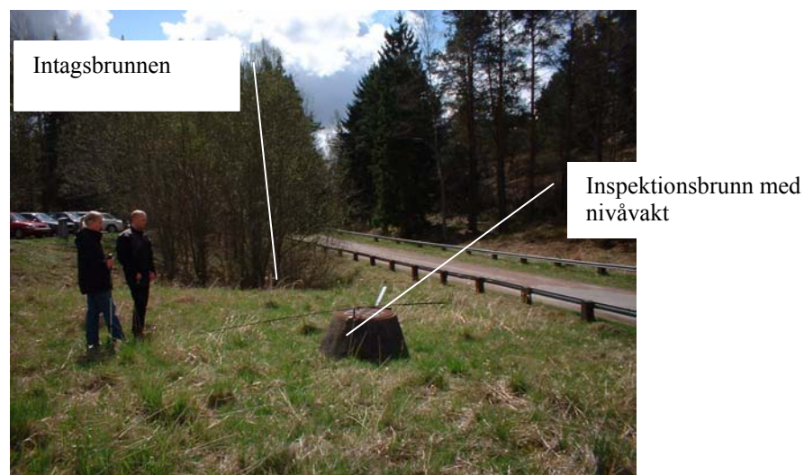
Figur 25. Nivåvakten i lakvattenledningen är placerad i en inspektionsbrunn.. Foto: A. Fersters.
