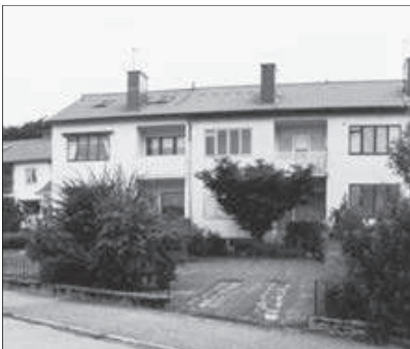
Kv 28, fasader mot trädgårdssidan.
