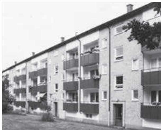
Kv 119, lamellbus med både entréer och balkonger mot "grönytan".
