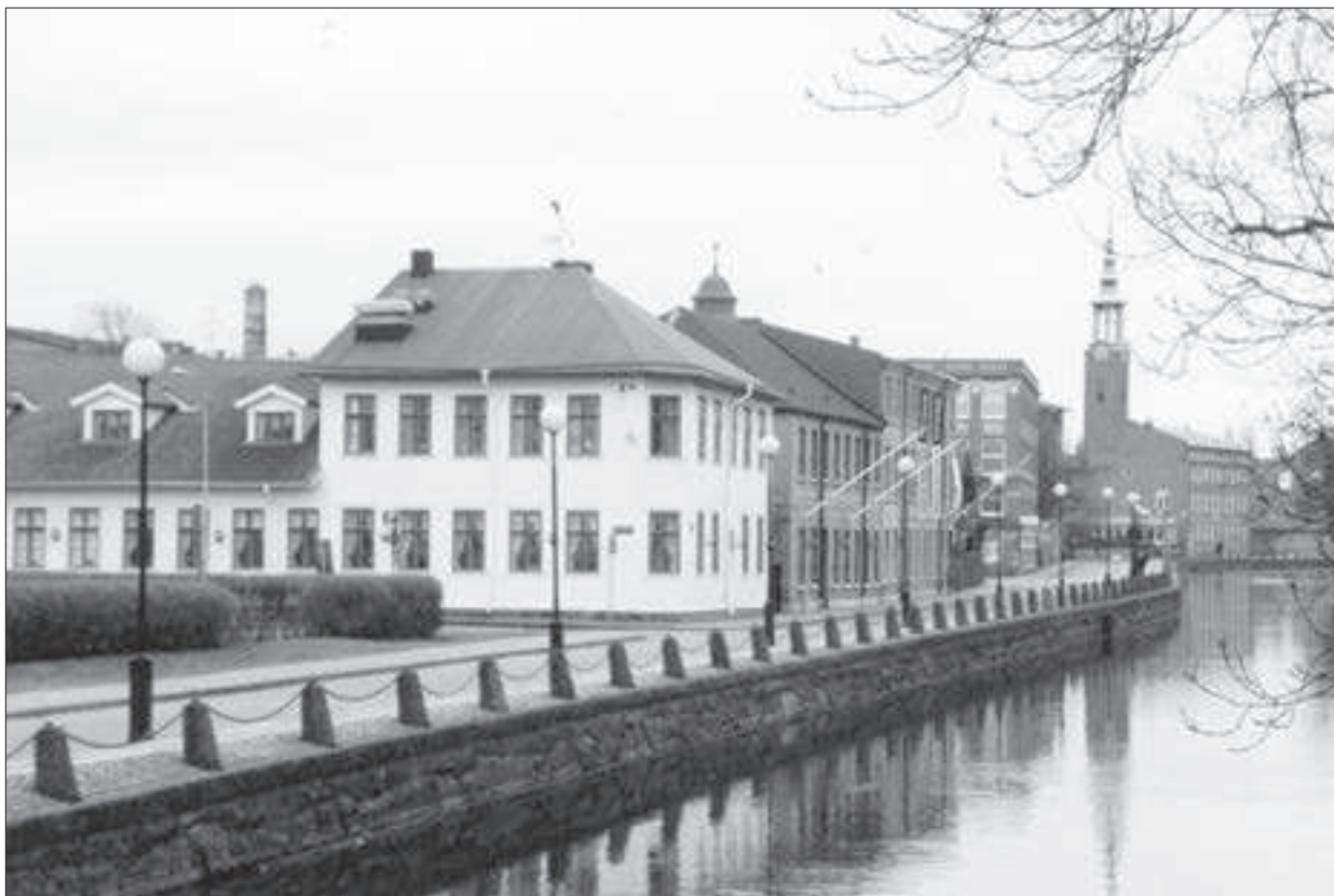
Mölndalsån och Åvägens gamla industrikvarter. Från vänster: f d Hästkosömfabriken, Remfabriken, f d Kamgarnspinneriet och f d Tomtens Fabriker.
