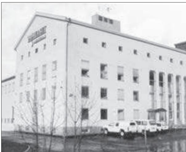
Alelyckans vattenverk II.
