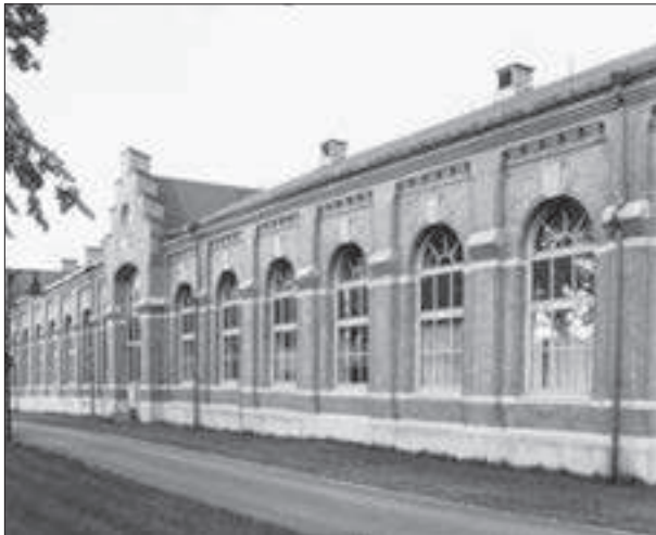
Alelyckans vattenverk I.
