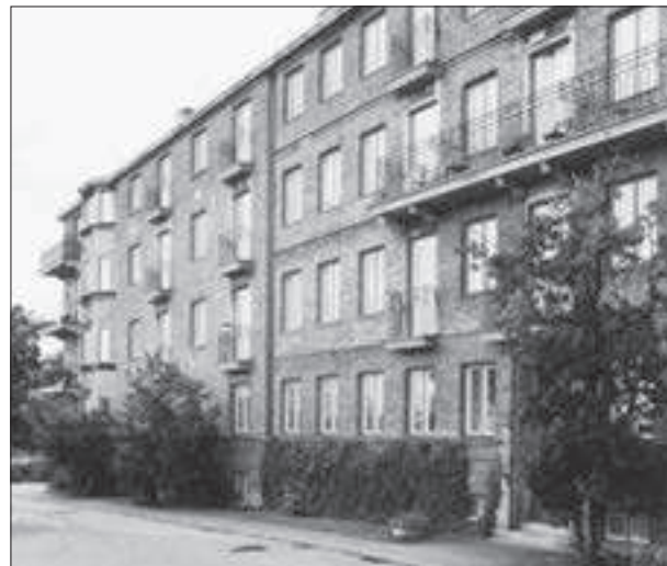
Kv 32, fasad mot väster.
