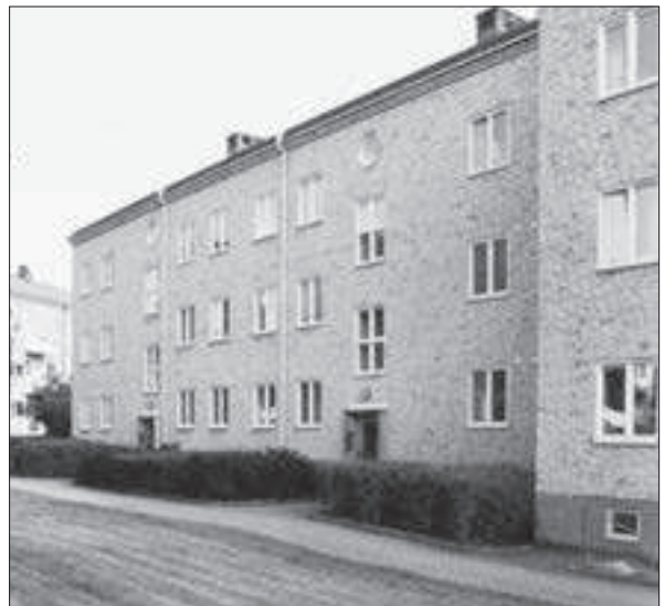
Kvarteret Smaragdödlan. Entréfasad i östra delen.
