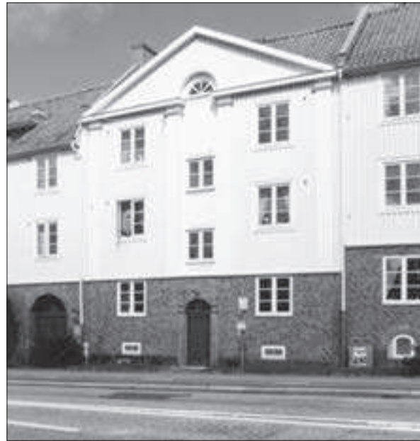
Kvarteret Halleberg. Fasad mot Härlandavägen.
