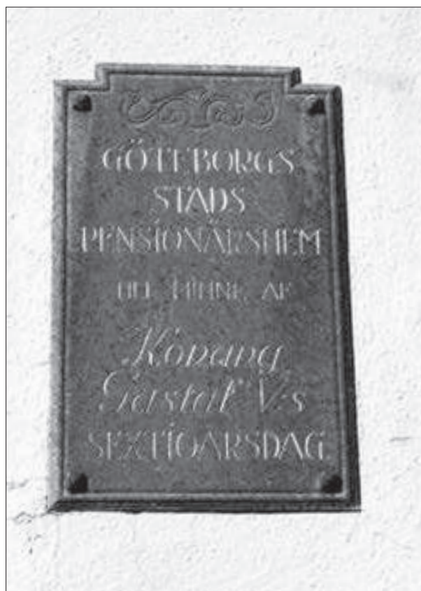
F d Pensionärsbem, kv 4:6. Kalkstensplatta på fasaden vid entrén mot Falkgatan.
