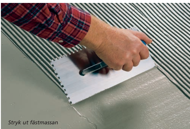
Var noggrann med att plattans baksida är helt täckt med fästmassa
