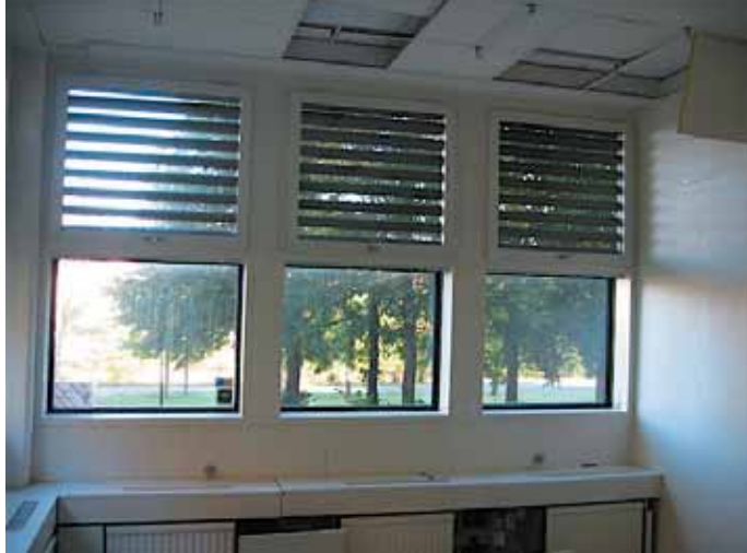
Kontorsrum i bottenvåningen
