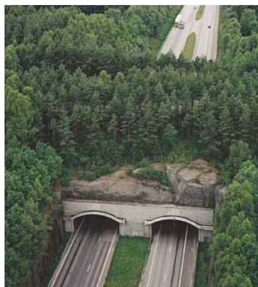
Jerikotunneln sedd från öster
